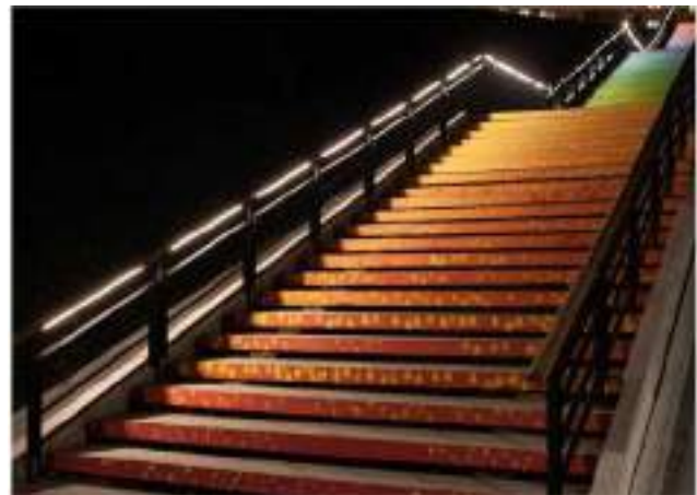
ИЛЛ. 4.1.18. ОБОРУДОВАНИЕ ДЛЯ ОСВЕЩЕНИЯ ОРГАЖДЕ- НИЙ И ЛЕСТНИЦ
